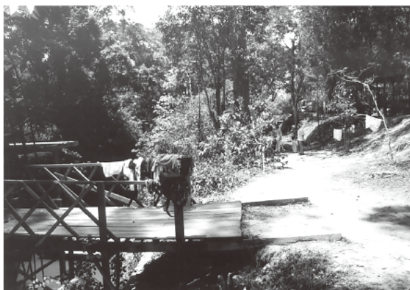
写真2 河床低下した現在のシェムリアップ川。右の路面が旧流路。そこから約5m低いところを流れている。
